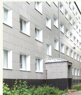
В общежитии №3 тепло и уютно. В здании заменили окна и отремонтировали фасад.
