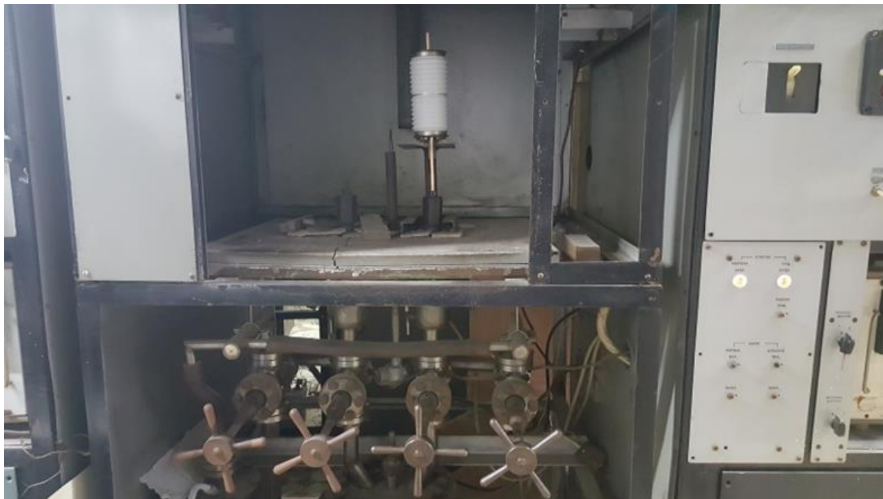
Рис. 1.8. Установка штенгельной камеры на откачку
